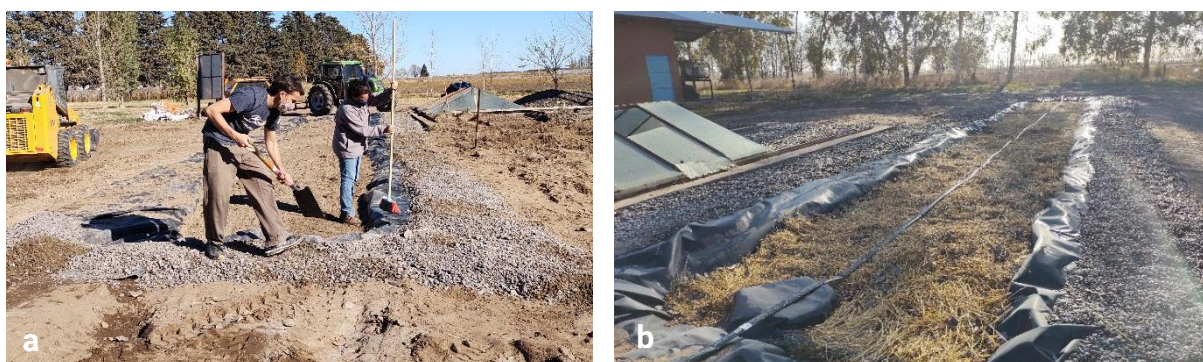
Figura 7. a- Sujeción de los bordes de la geomembrana con canto rodado. b- Cobertura con pasto seco y riego durante 30 días para activar la biomezcla.
