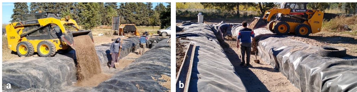
Figura 5. a- Volcado de arena para formar la primera capa del piso. b- Volcado de canto rodado para completar la capa de drenaje.
