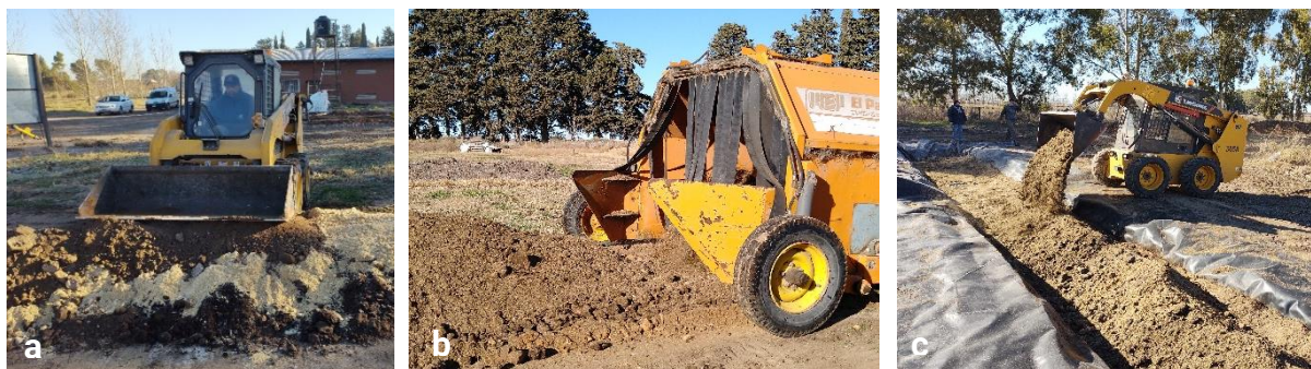
Figura 6. a- Pila formada con los 3 materiales con componen la biomezcla. b- Máquina volteadora que se utilizó para mezclar los materiales. Se observa la uniformidad en el color de la pila luego del proceso de mezclado. c- Llenado de la cama con la biomezcla.
