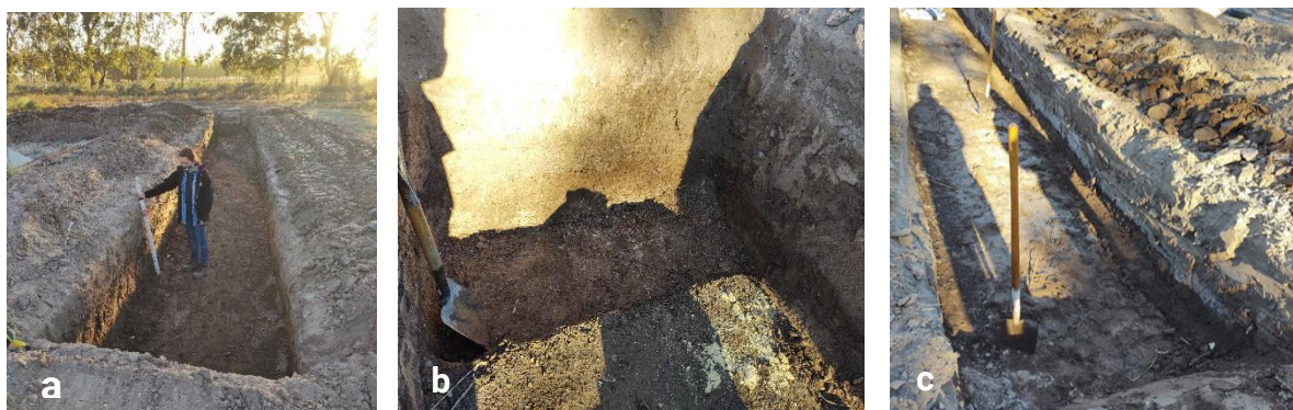
Figura 3. a- Pozo excavado. b- Detalle de la cabecera de la cama c- Ducto lateral para el drenaje.
