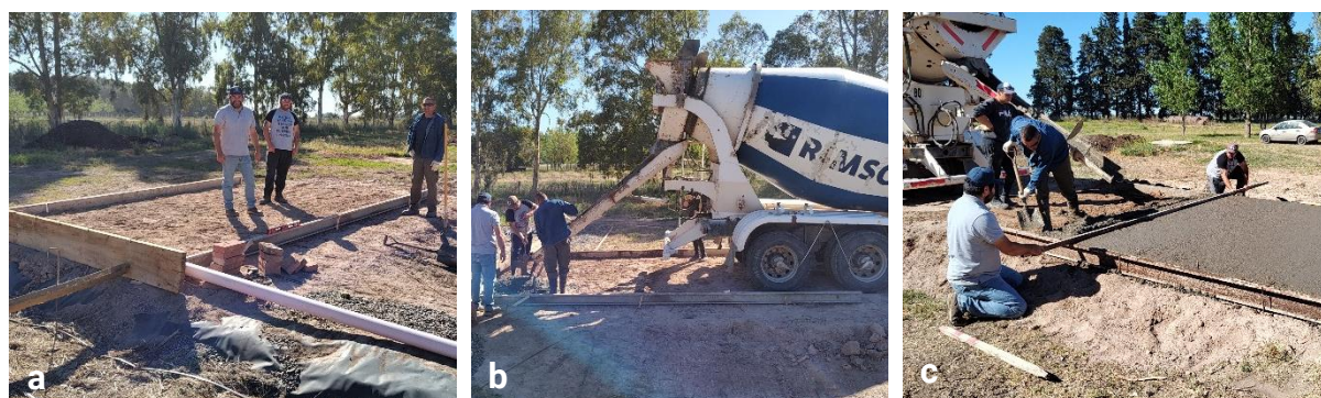
Figura 9. a- Armado y nivelación de la estructura para contener el hormigón y el sistema de desagüe de líquidos. b- Volcado de hormigón. c- Nivelación del suelo con las pendientes necesarias para dirigir los líquidos residuales.
