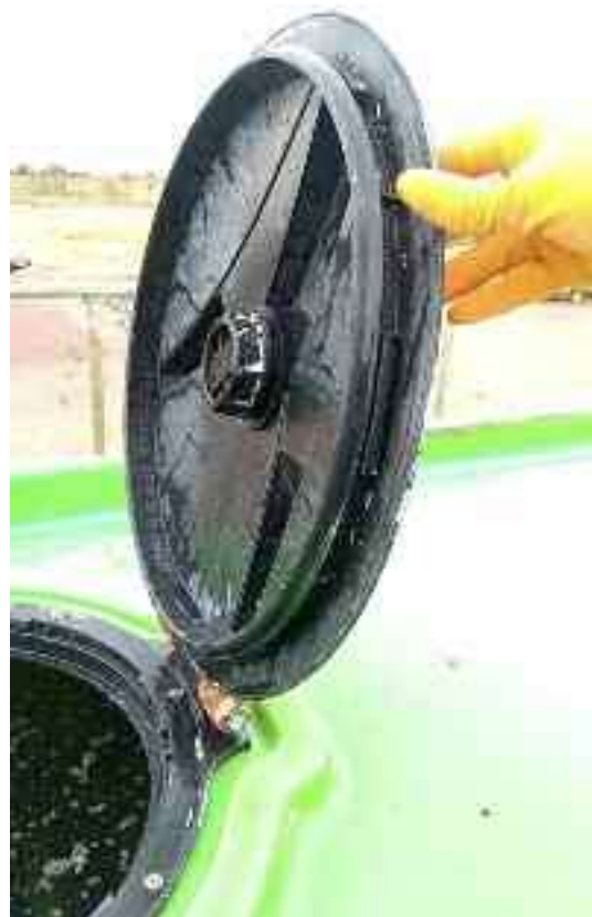
Figura 1 | Tapa del depósito en buen estado y con anillo de goma para evitar fugas.
