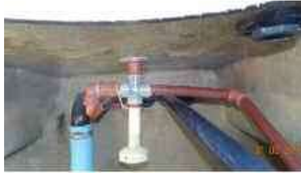
Figura 4 | Bomba de pulverización sin fugas visibles.
