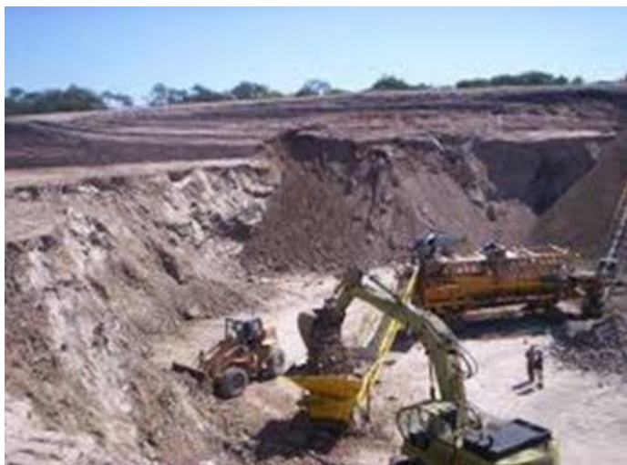
Excavación y carga con cargador frontal – Entre Ríos
